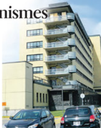
Depuis 1985, c'est plus de 4M$ que la Fondation a versé en équipements et aménagements à l'Hôpital de Jonquière. (Photo: Jean Marc Tremblay)
